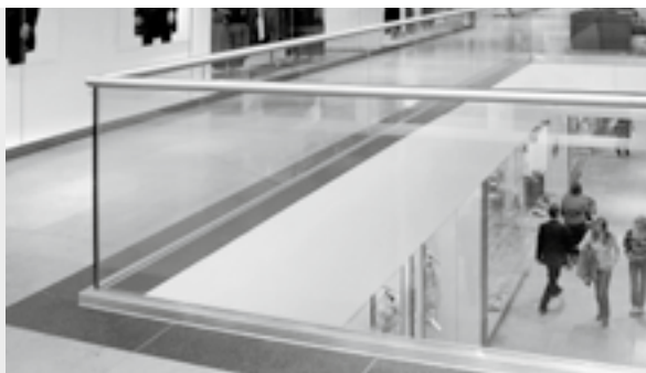
V budově, shora v rovině s podlahou
